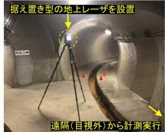
写真3 地上レーザスキャナによる点群データの取得状況
