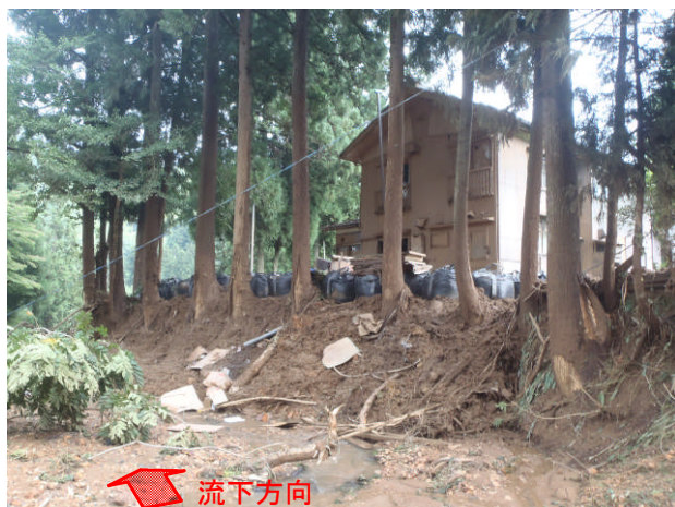
写真 2-3. 杉皮の剥がれと窓の損傷
