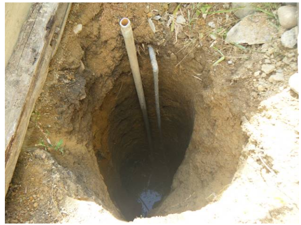
写真.6 滑落崖後方の緩斜面(人家脇)の浅井戸
