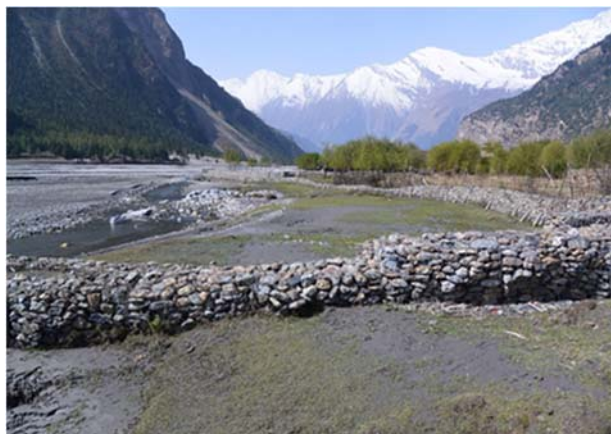
写真-2 施工後 20 年の写真 1 の地すべり地(2018 年 3 月)
