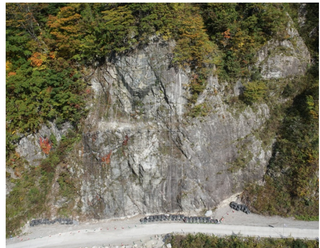
図-12 落石対策工設計
