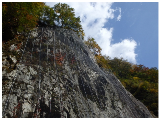
図-13 落石対策工施工状況
