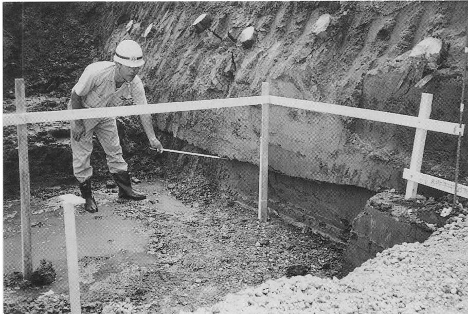
写真-1 掘削法面に発生したすべり面(亀裂番号①)。すべり面は風化泥岩の層内に形成された。
