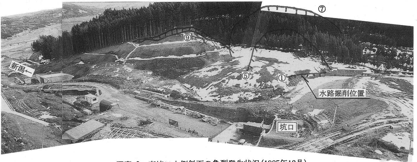
写真-2 東坑口山側斜面の亀裂発生状況(1985年12月)
