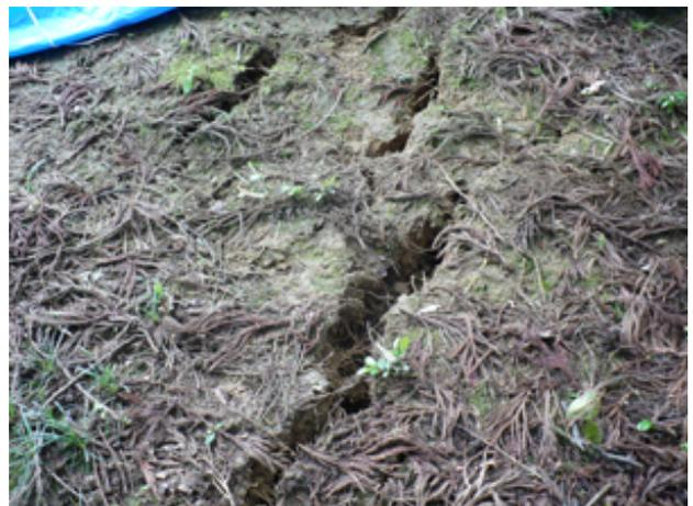
写真－10 民家裏手の斜面頂部の亀裂（刈羽村赤田北方地内）
