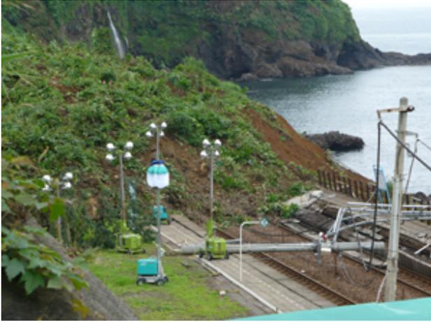
写真－1 1 崩壊土砂による線路の埋積（JR青海駅近く。柏崎市青海川）
