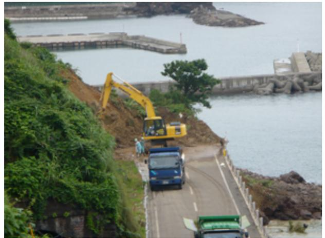
写真－1 4 柏崎市笠島地内で発生した斜面崩壊
