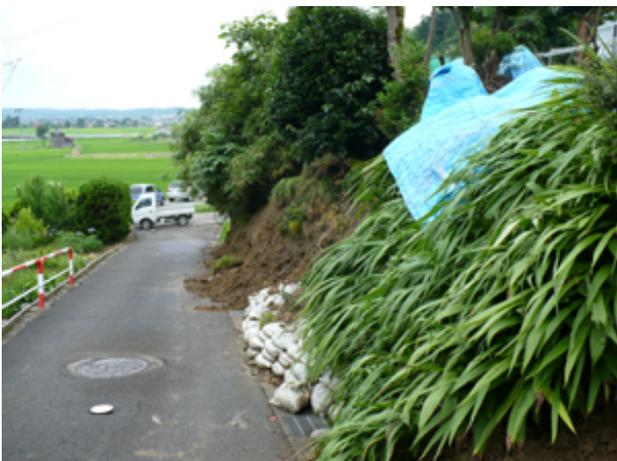
写真－9 宅地造成盛土斜面の孕み出し（刈羽村赤田北方地内）
