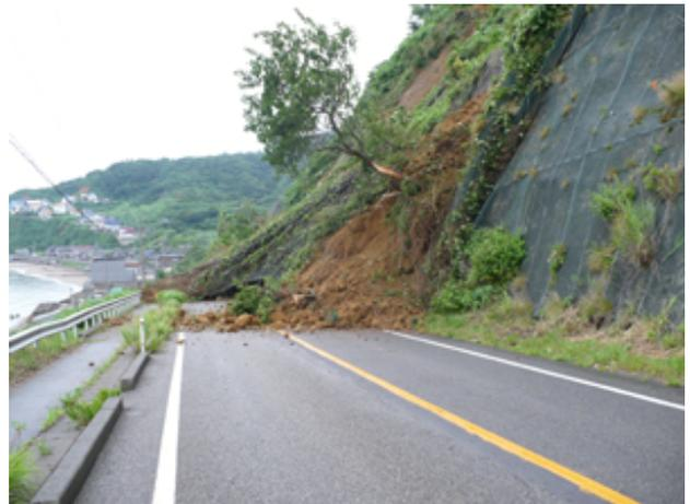
写真－2 国道352号線の崩壊土砂（柏崎市椎谷・観音崎）
