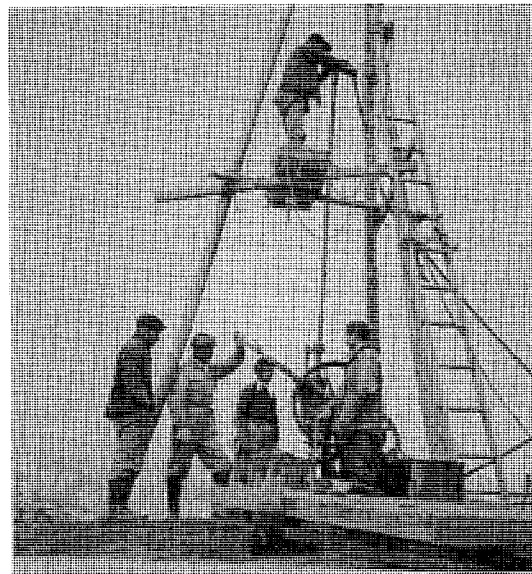
写真2.6.42 県直営の調査ボーリングの様子
