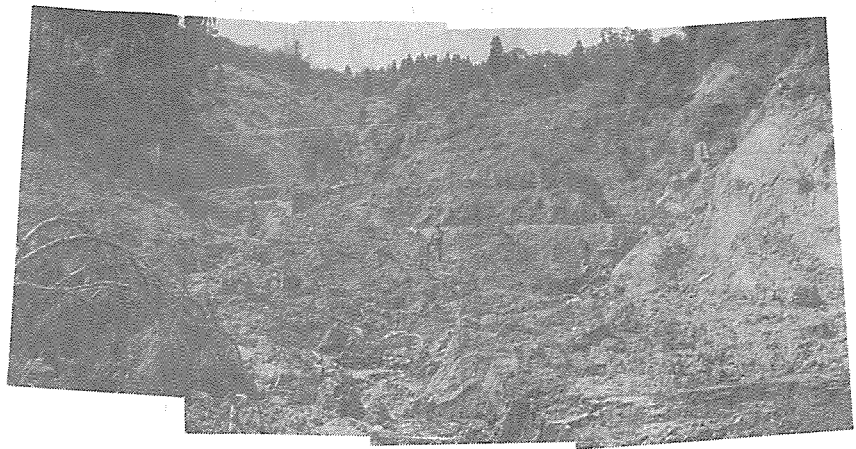
写真－1 昭和49年4月10日地すべり発生 谷止工(10基)倒壊，これにより300m下流まで土砂が決出した
