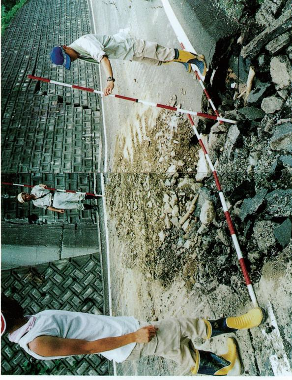
写真⑦ クラックや沈下が拡大したため、応急の路面維持
