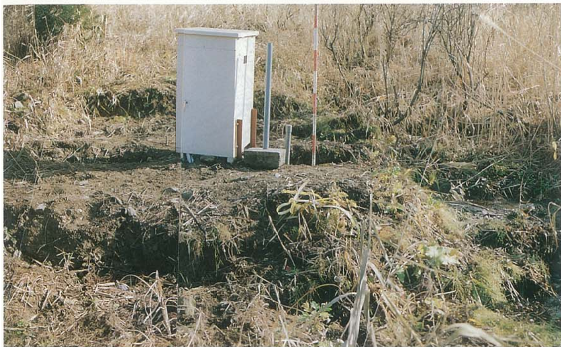
写真－3 BV3－1多層移動量計付近の亀裂（平成3年12月3日）
