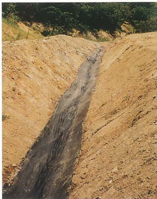
写真－4 厚地ゴムシートばりの仮設水路の現況（平成6年8月18日） 平成6年融雪期に融雪水のために破損したものを張り直した。
