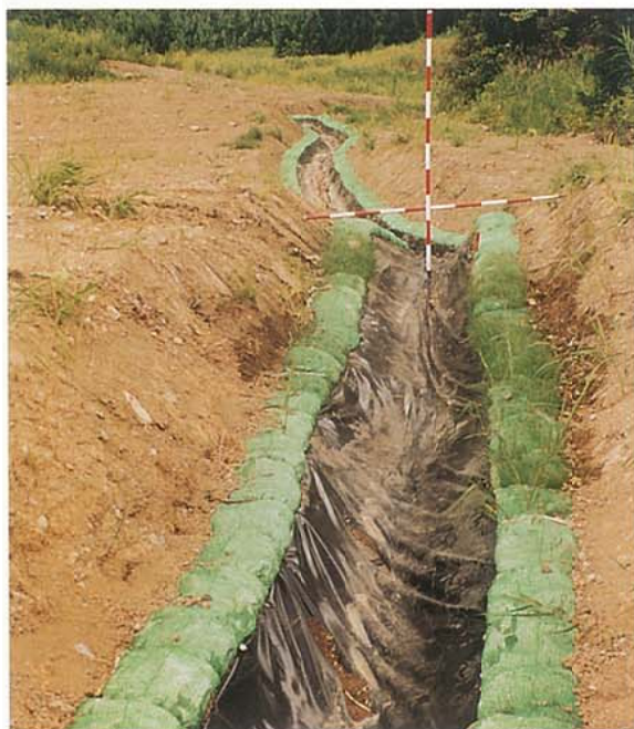
写真－4 厚地ゴムシートばりの仮設水路の現況（平成6年8月18日） 平成6年融雪期に融雪水のために破損したものを張り直した。
