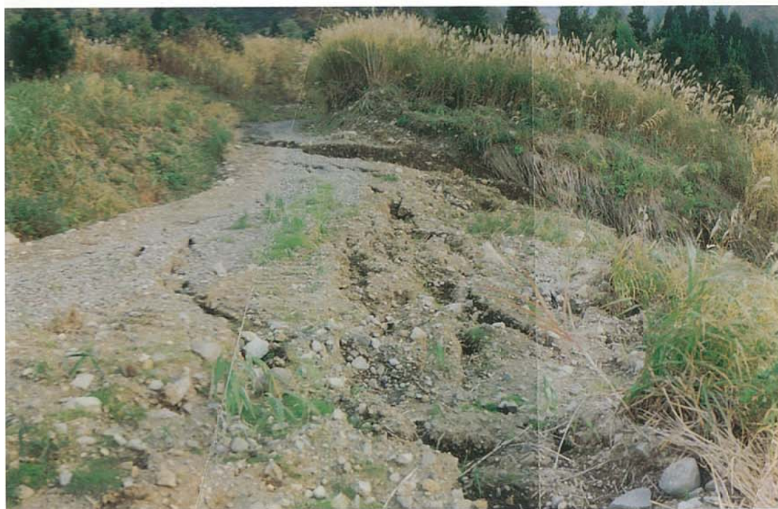
写真－2 石倉ブロックを横断する林道に発生した亀裂（平成2年11月3日）
